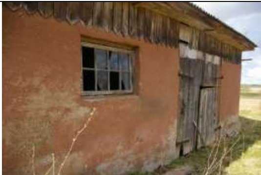
1.zemes vienība ar kadastra apzīmējumu 6498 001 0158, Būve (saimniecības ēka) ar kadastra apzīmējumu 6498 001 0158 002
